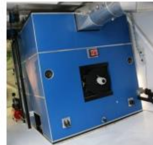
Træpillefyr til store bygninger (250 kW)
